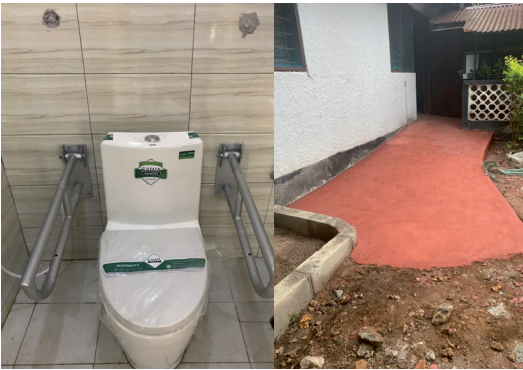
Mtwaran Finnclubilla on saatu paljon aikaan. Liikuntarajoitteisille henkilöille on rakennettu mm. kulkurampeja ja esteetön WC. Samoin keittiö on esteetön ja lavuaarit alempana.
